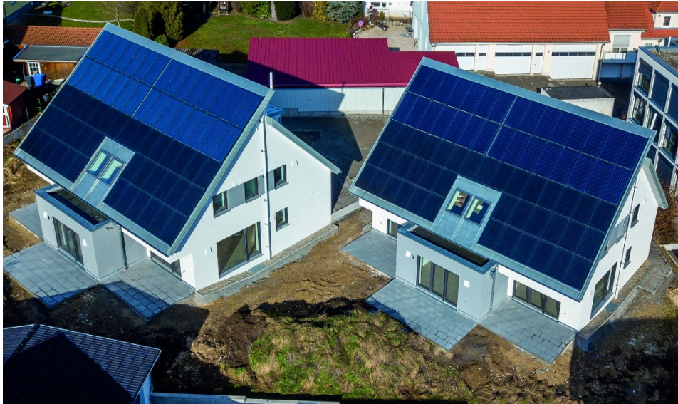
↗ Abb. 11: Investition in Mehrfamilienhäuser: Die VR-Bank Ostalb eG Aalen investiert als erste Bank 2019 in zwei energieautarke Mehrfamilienhäuser mit je drei Wohneinheiten. Die Bank vermietet die Häuser mit Pauschalmiete und Energieflat; all inclusive: Wärme, Strom und E Mobilität. Bildquelle: VR-Bank Ostalb eG
