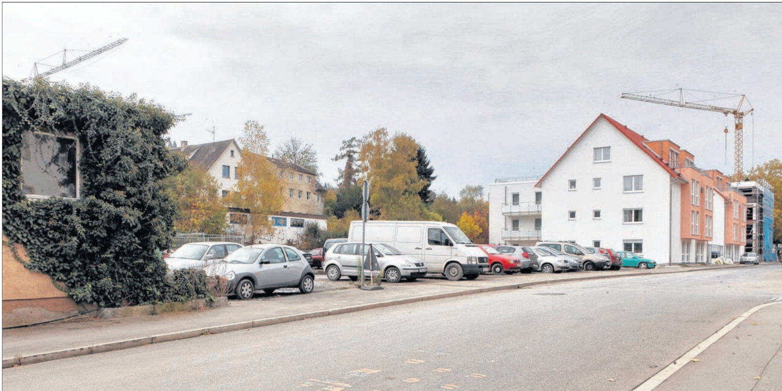
Noch Parkplatz – bald Bauplatz: Am Montag vergab der Tübinger Rat eine Kaufoption für die letzte freie Fläche auf dem alten Bauhof-Areal am Schleifmühlweg. Bild: Metz
